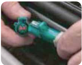
Compruebe todas las conexiones eléctricas
